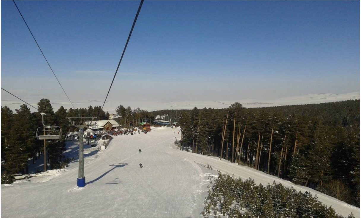
Şekil.7. Bayraktepe Kış Sporları Merkezi Güneşli Konaklama Tesisleri
