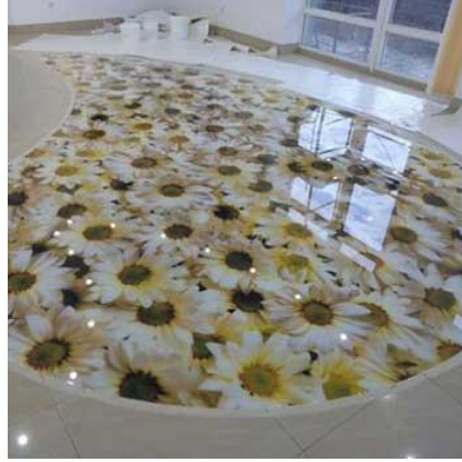
Görsel 9: epoksi zemin uygulaması URL:
