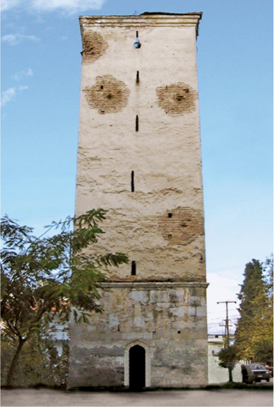
Saat Kulesi, Yenice-i Vardar (Restorasyon Öncesi)
