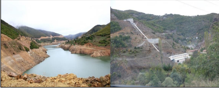
Foto 80: HES, Baraj ve Yol Çalışmalarıyla Tahrip Edilen Ormanlık Sahalara Örnekler.
