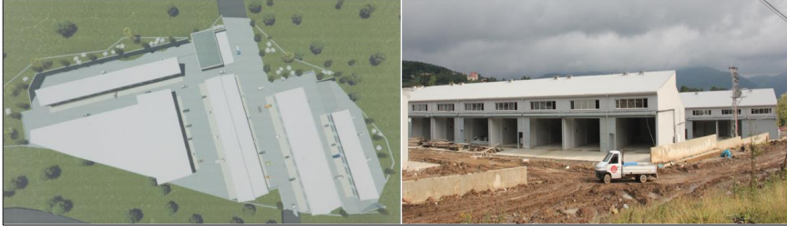
Foto 62: Yapım Aşamasında Olan Gökçöy Sanayi Sitesi.
