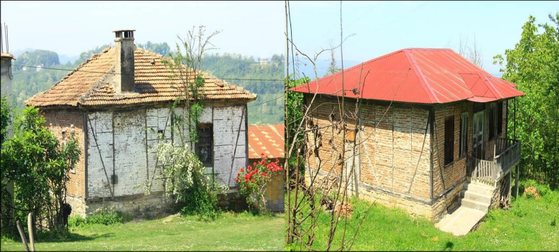
Foto 31: Arpaköy ve Kumrulu Mahallesiinde Havzanın Yöresel Mimari Özelliğini Yansıtan Ahşap Destekli Tuğla Dolgulu ve Mesken Olarak Kullanılan Eski Yapılar.
