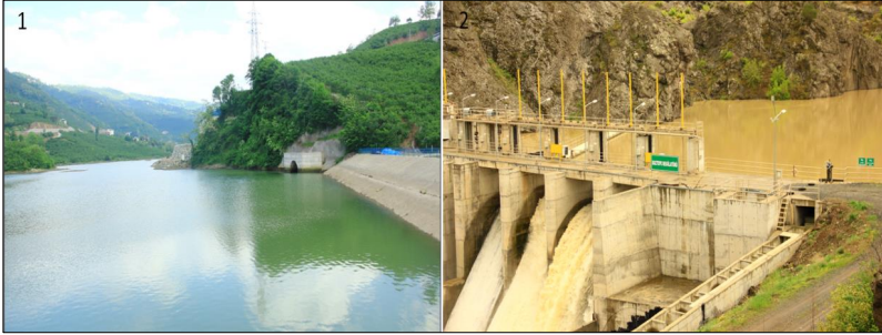
Foto 18: Ordu HES'in Su Toplama Alanı (1) ve Boztepe Hidroelektrik Santralinin Regülatörü (2)
