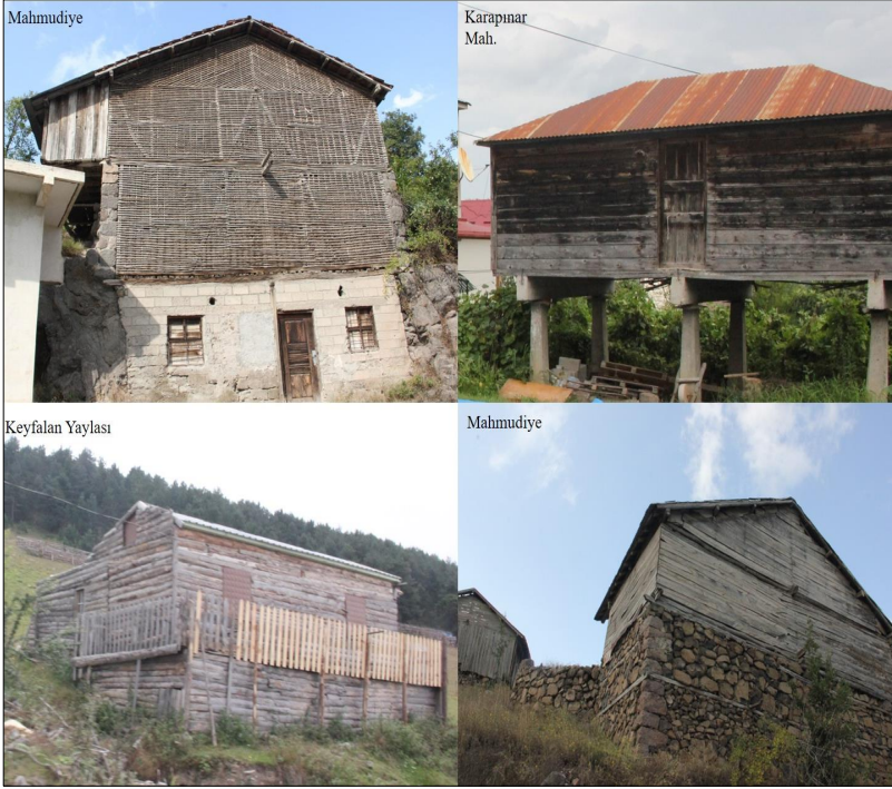
Foto 32: Havzanın Farklı Yerlerinde Mesken ve Depo Amaçlı Kullanılan ve Ahşap Malzemeden Yapılmış Yöresel Yapılar.
