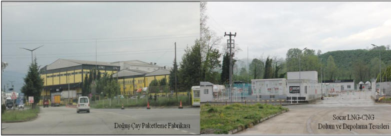
Foto 55: Çay Paketleme ve Doğal Gaz Depolama ve Dolum Tesisleri.
