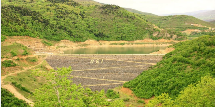
Foto 17: Topçam Mahallesinde Bulunan Topçam Barajının Seddesi ve Su Toplama Alanı
