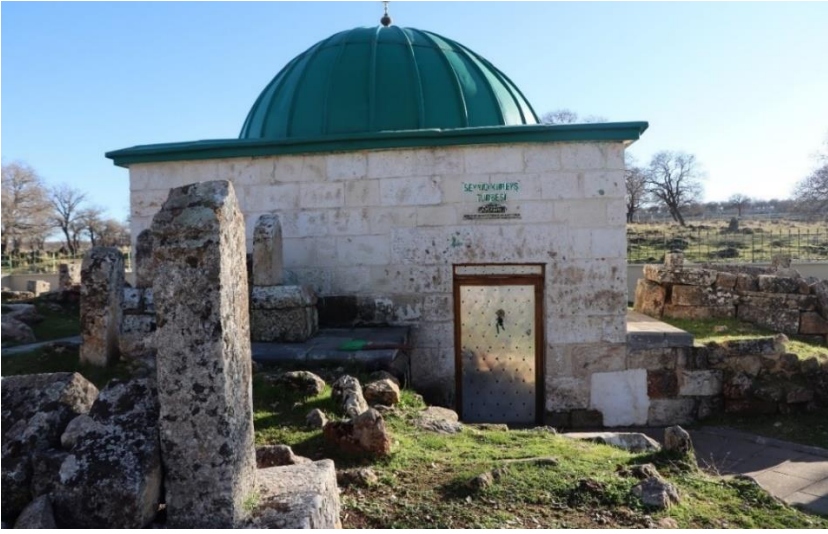
Şekil 4.5. Hacı Koreş Türbesi
