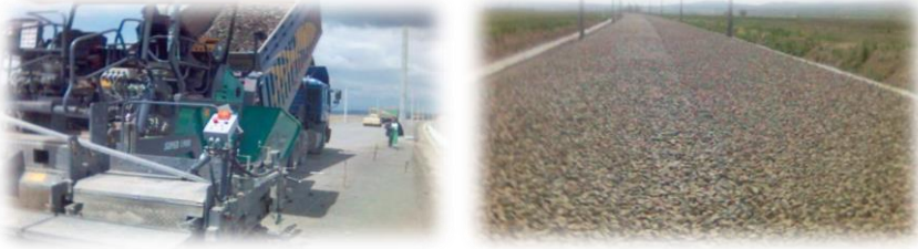
Şekil 3. 10. Platform ve üzerine balast serimi.
