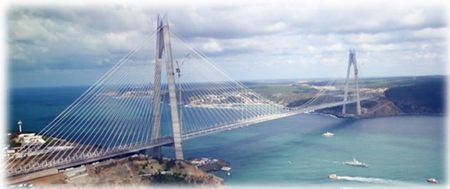
Şekil 3. 3. Yavuz Sultan Selim Köprüsü.
