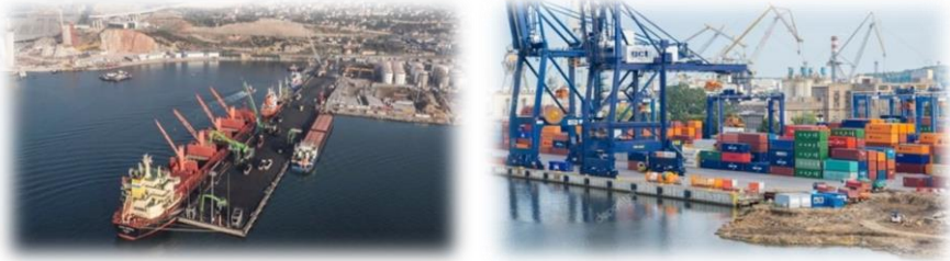
Şekil 3. 17. Kuru yük ve konteyner terminali.
