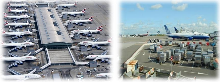
Şekil 3. 23. Yolcu ve kargo terminali apron görünümü.
