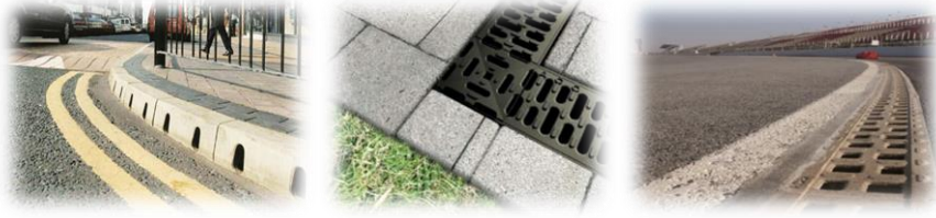
Şekil 3. 8. Yollarda alınan örnek drenaj önlemleri.
