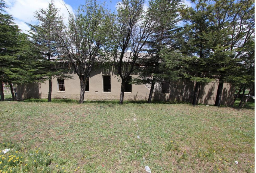
Fotoğraf 48: Bademli İlkokulu Güney Cephesi
