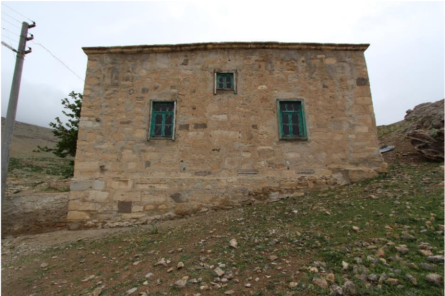
Fotoğraf 3: Sığracık Köyü Eski Camii Kible Cephesi
