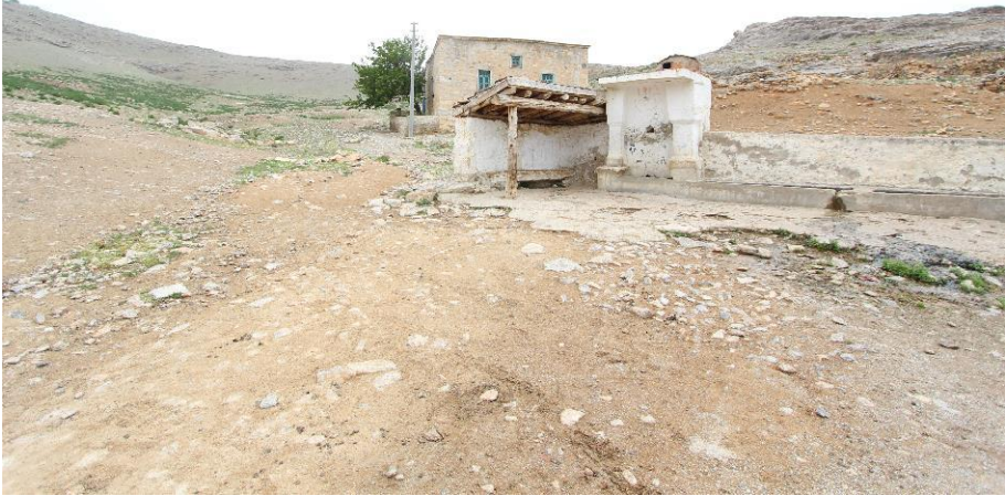
Fotoğraf 1: Sığracık Köyü Eski Camii Genel Görünüşü
