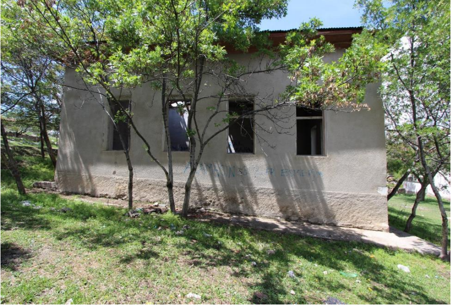
Fotoğraf 49: Bademli İlkokulu Doğu Cephesi
