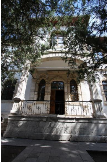
Fotoğraf 16: İnkılâp Ortaokulu Güney Cephesi
