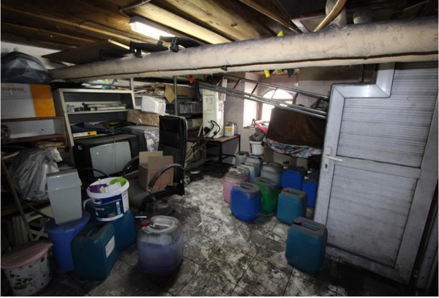
Fotoğraf 29: İnkılâp Ortaokulu Bodrum Katta Kuzeybatıdaki Depo
