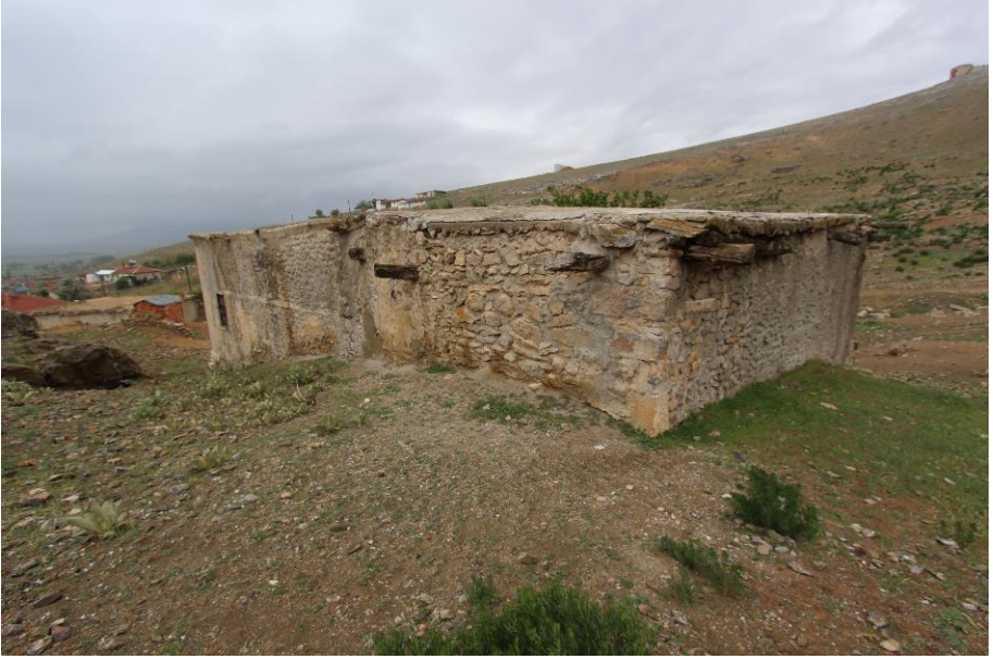
Fotoğraf 6: Sığracık Köyü Eski Camii Kuzeydoğu Cephesi
