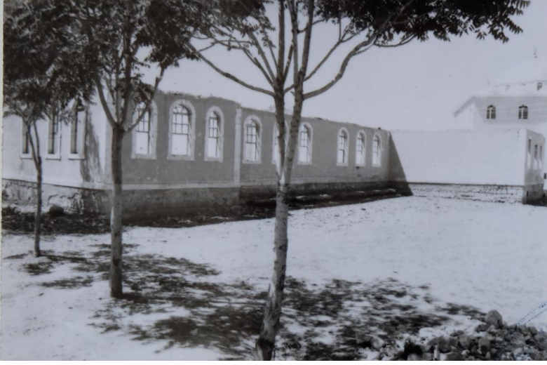
Fotoğraf 37: Davulga Eski Mektep Denilen Binanın Yıkılmadan Önceki Durumu 1994. (Afyonkarahisar Müze Müdürlüğü Davulga Eski Mektep Binası Dosyasından)
