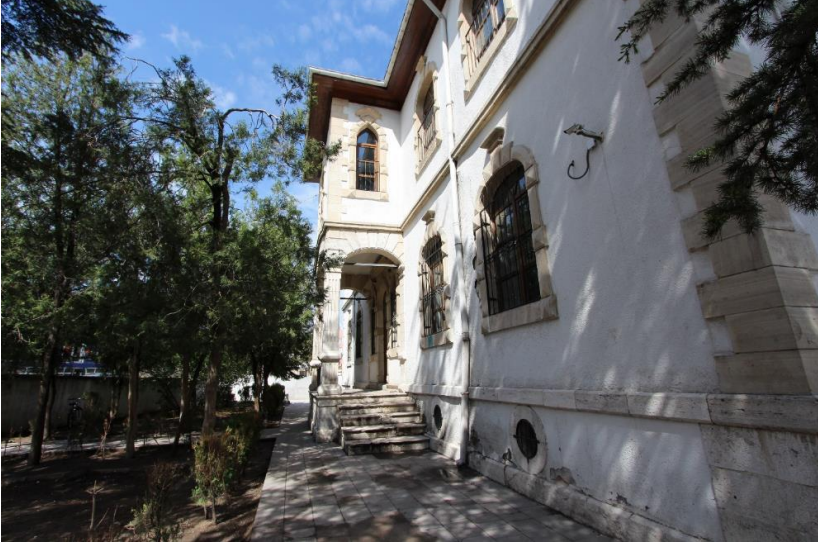
Fotoğraf 15: İnkılâp Ortaokulu Güneydoğu Cephesi
