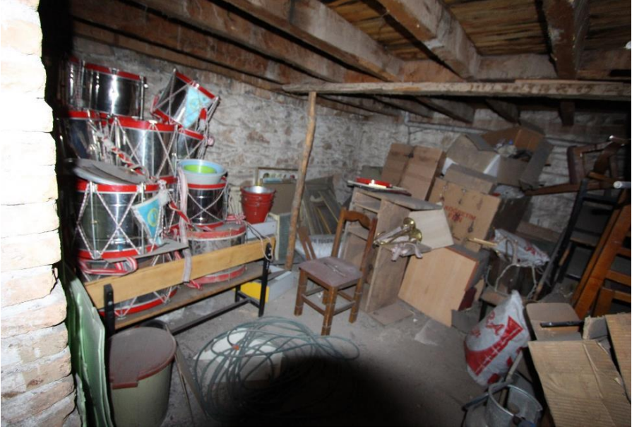
Fotoğraf 31: İnkılâp Ortaokulu Bodrum Katta Depo Olarak Kullanılan Birim
