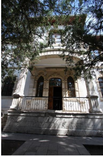
Fotoğraf 16: İnkılâp Ortaokulu Güney Cephesi
