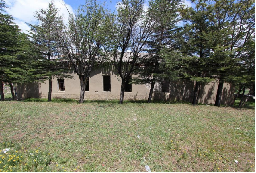
Fotoğraf 48: Bademli İlkokulu Güney Cephesi
