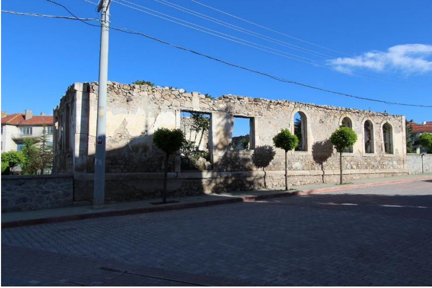
Fotoğraf 39: Davulga Eski Mektep Denilen Binanın Batı Cephesi
