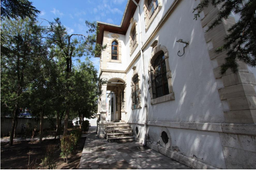
Fotoğraf 15: İnkılâp Ortaokulu Güneydoğu Cephesi
