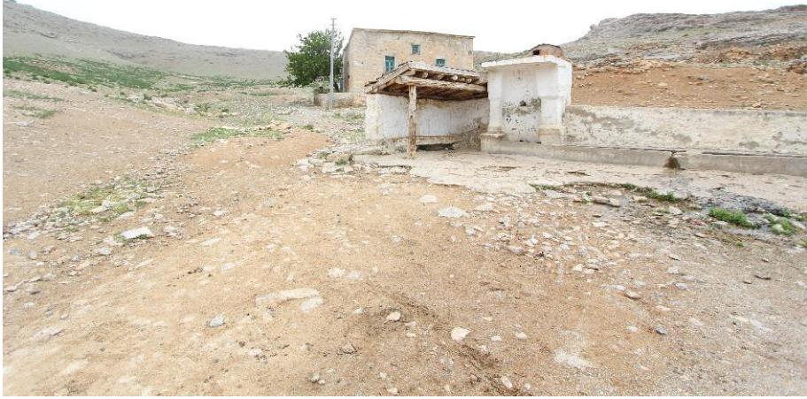
Fotoğraf 1: Sığracık Köyü Eski Camii Genel Görünüşü
