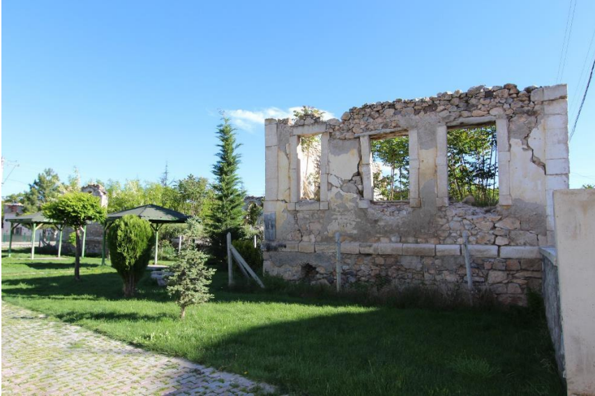
Fotoğraf 38: Davulga Eski Mektep Denizlen Binanın Kuzeybatı Cephesi
