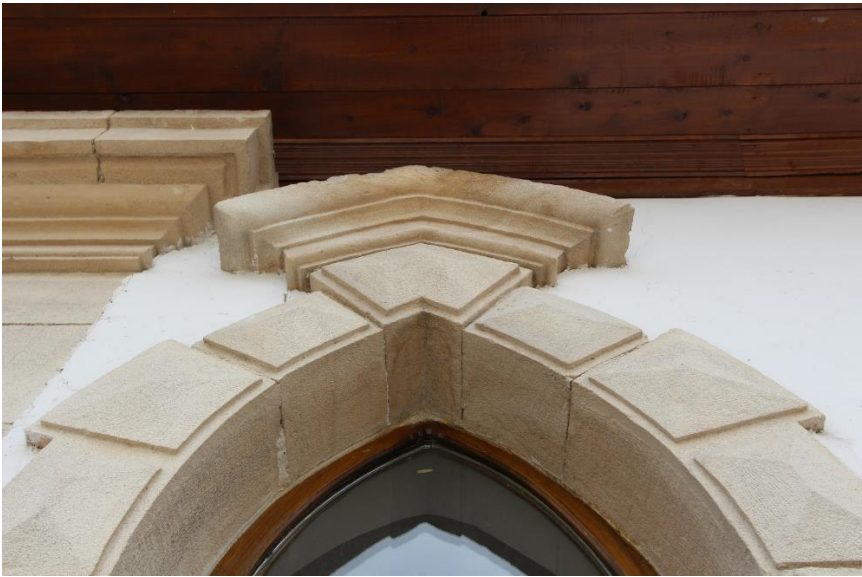
Fotoğraf 32: İnkılâp Ortaokulu Pencere Kemer Kilit Taşı Detayı
