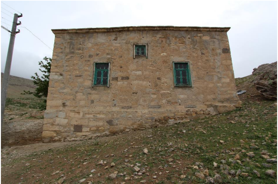
Fotoğraf 3: Sığracık Köyü Eski Camii Kible Cephesi
