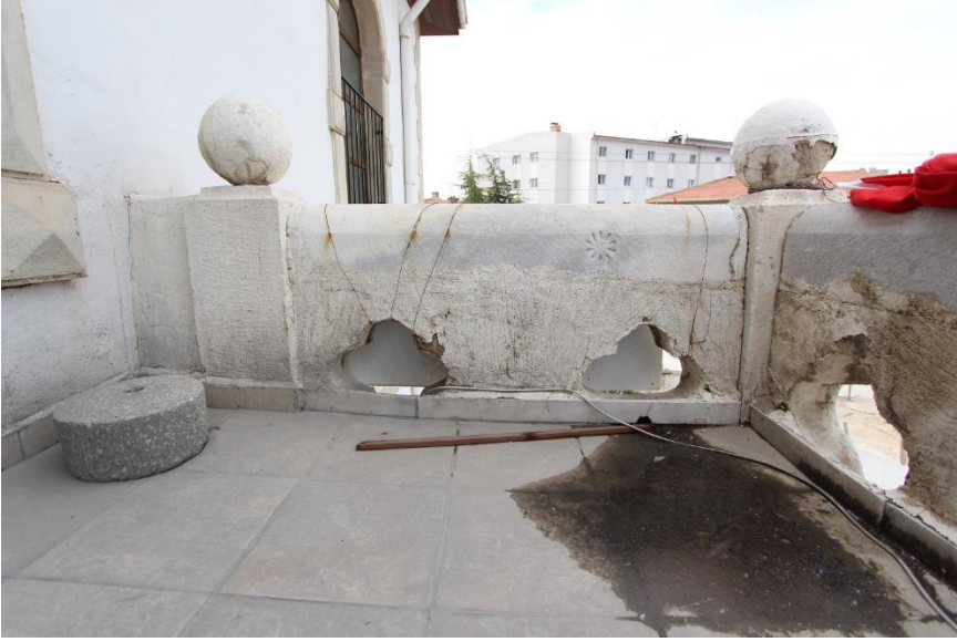
Fotoğraf 27: İnkılâp Ortaokulu Birinci Kat Balkon Korkuluk Detayı
