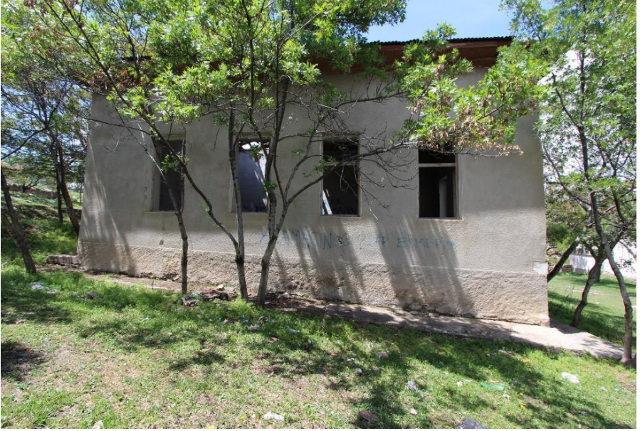
Fotoğraf 49: Bademli İlkokulu Doğu Cephesi
