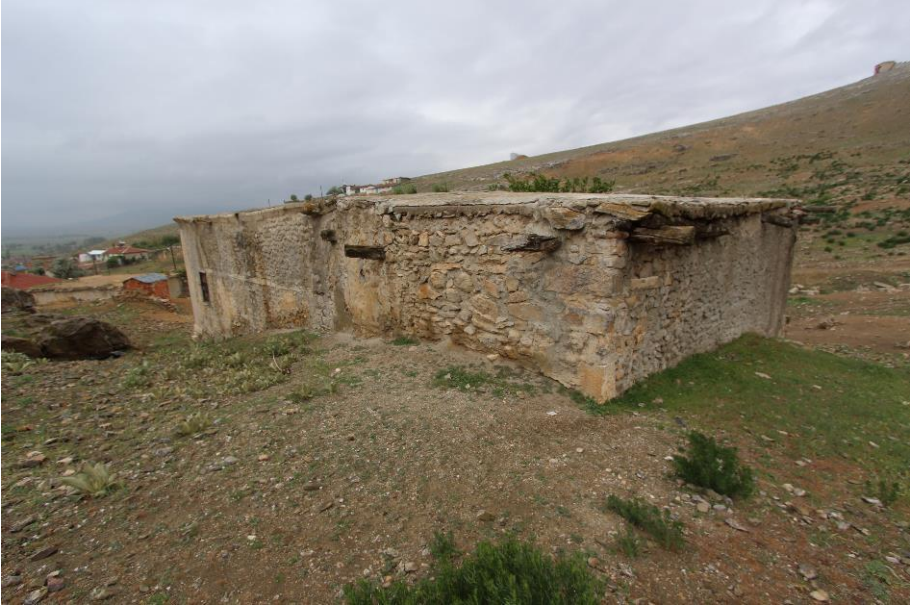
Fotoğraf 6: Sığracık Köyü Eski Camii Kuzeydoğu Cephesi
