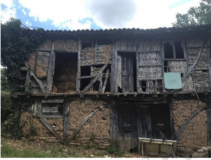
Köy evi, alt kat hatıl arası kerpiç dolgu, üst kat ahşap karkas arası fındık dalları ile çitme tekniğinde ve üzeri balçık sıvalı (foto:T.Çoruhlu)
