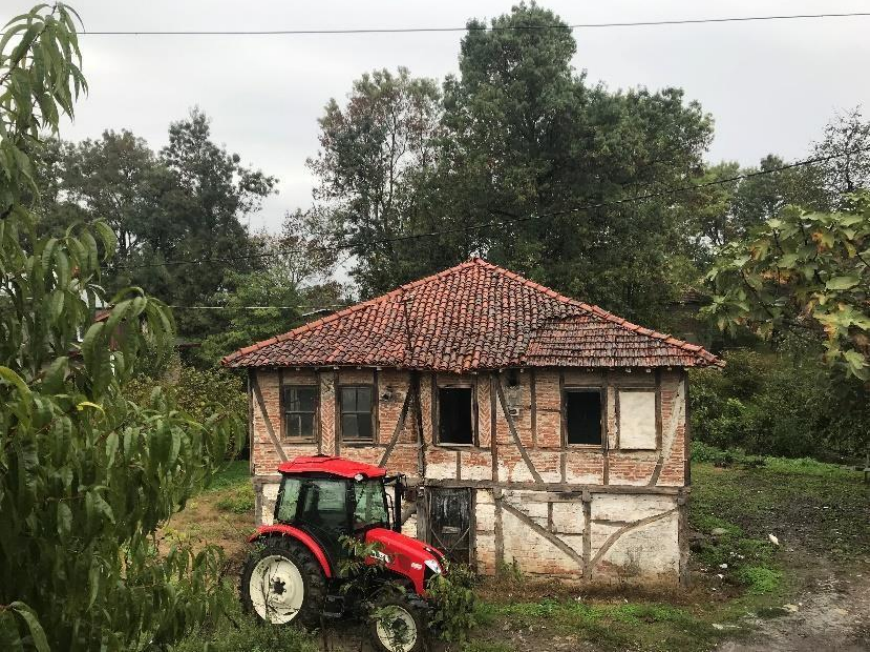
Ky evi, ağřap karkaslı dolgu duvar (foto:T.oruhlu)
