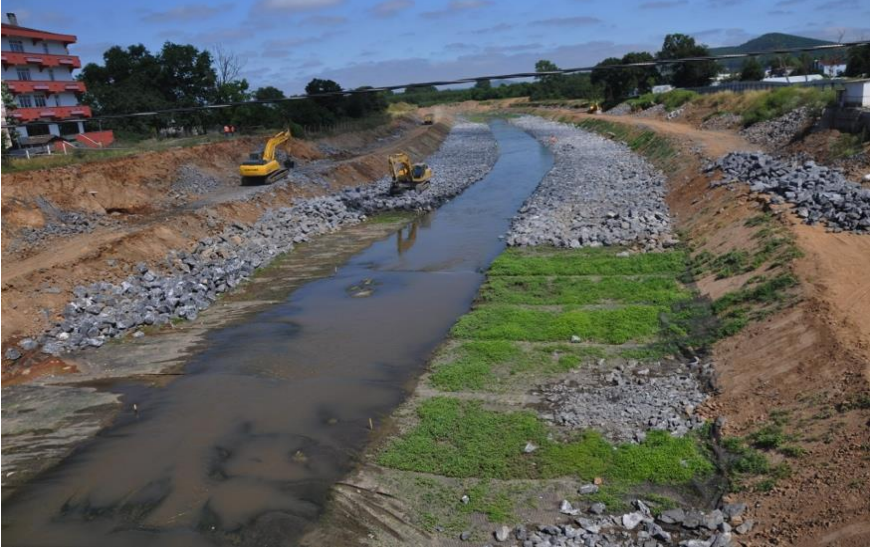
Foto 39. Riva nehri üzerinde yapılan yatak düzenleme çalışmaları
