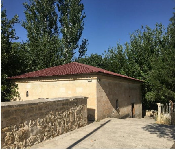
Ek: 10 Seyyid Bedreddin Türbesi'nin Batı Taraftan Dış Görünüşü
