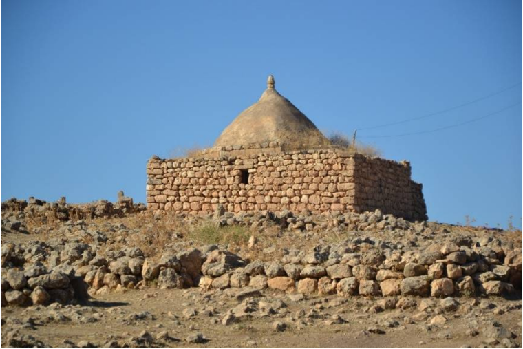
Mardin Derik Dedeköy Dede Garkın Türbesi Dış Görünüm
