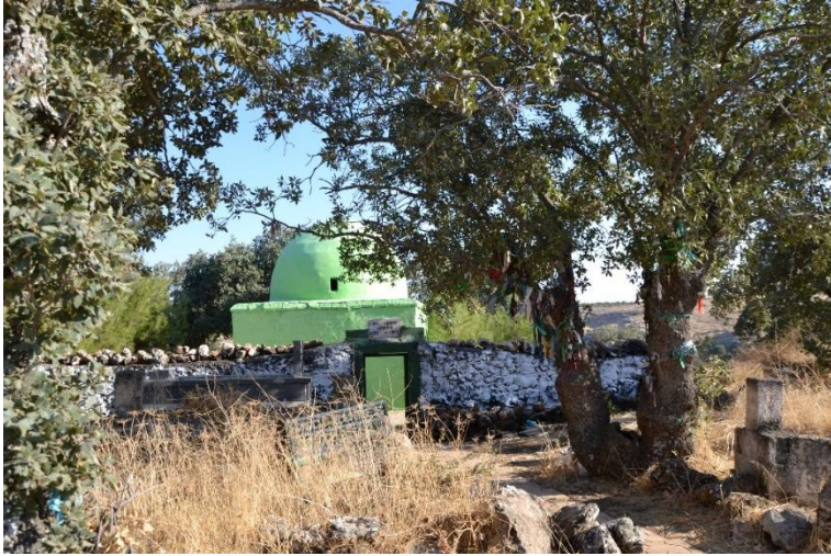
Gaziantep Yavuzeli Yukarı Kayabaşı Köyü Hacı Kureyş Türbesi Dış Görünüm
