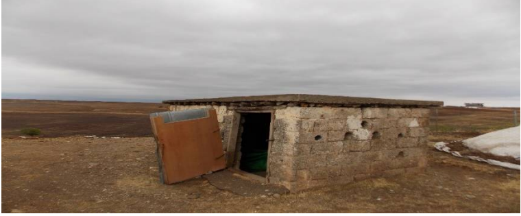
Dolu Baba'nın dıştan görünümü.
