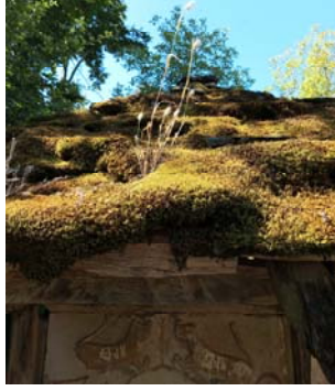
Resim 8 Sinop, Ayancık, Otmanlı Çeşmesi, Kuzey Cephe, Zararlı Boyalar, Liken ve Yosunlanma
