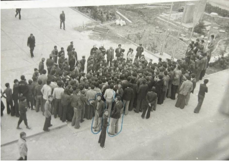
Görsel 54. 175 Edirne Erkek Öğretmen Okulu önünde Atatürk Büstü'nün yerleştirileceği inşa halindeki beton platform, 1974. Fotoğrafta işaretlenmiş kişilerden sağda sırtı dönük olan Rıza Oruç.
